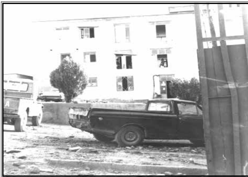
نمایی از ضلع غربی ساختمان باشگاه افسران سنندج - ۱۳۵۹
